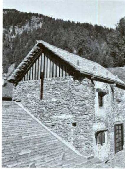
Die Casa La Vedola beherrscht das kleine Ensemble und gewährt den aufregendsten Ausblick von der Terrasse. Hinter den alten Brettern im verglasten Giebel liegt ein Schlafzimmer mit Einbauschränken.
