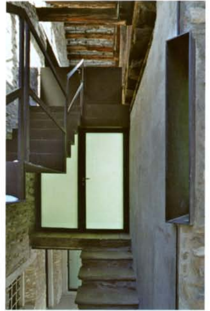
Moderne Materialien im Kontrast zum alten Mauerwerk
