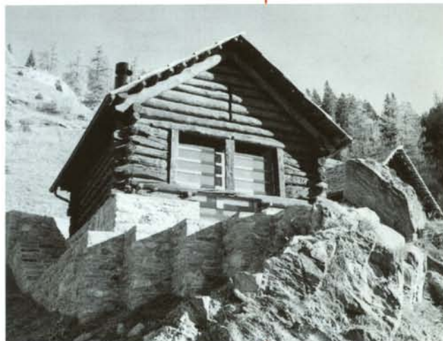
Nel rustico «Cassè» è stato fedelmente ricostruito l'antico tetto in scandole di legno. L'interno offre confortevoli spazi. Foto G.L. Dazio.
