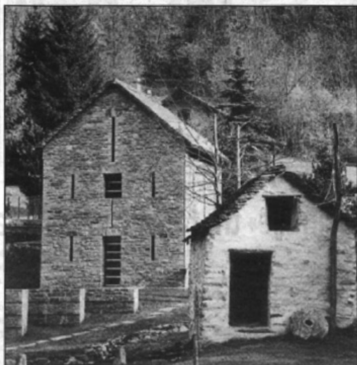
La casa «Al Faro» a Mogno spicca per la sua verticalità e l'armonioso passaggio tra la vecchia centralina elettrica e una sperimentazione architettonica che innova le linee del passato. Nella foto piccola (tratta da Metrocubo ) l'architetto Giovan Luigi Dazio.
